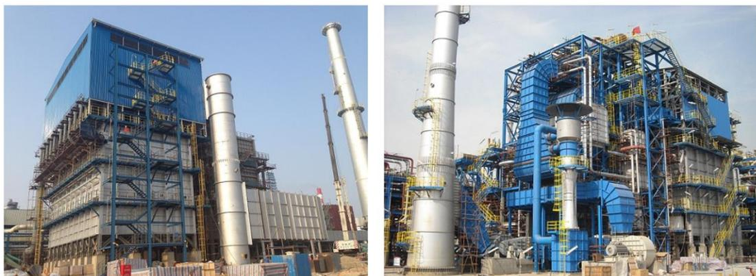
转化炉是一种非常特殊的外热式列管反应器，由于转化反应的强吸热及高温等特点，这种反应器被设计成加热炉的形式，催化剂装在一根根的转化炉管内，在炉膛内直接加热，反应介质通过炉管内的催化剂床层进行反应。转化炉苛刻的操作条件，使得转化炉有很多有别于其它加热炉的特殊性，在炉体结构、炉管材料、管路系统支撑、管路系统应力、管路系统膨胀及补偿、燃烧、烟气流动及分配、耐火材料等各方面都必须精心考虑。
